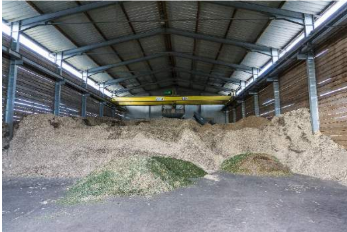
Abbildung 8: Holzschnitzellager für das Holzheizkraftwerk
